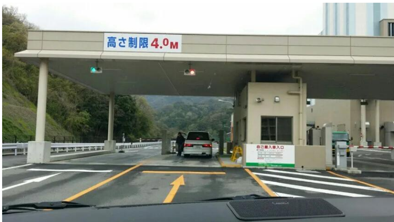
エコクリーン松江 ごみの搬入口
