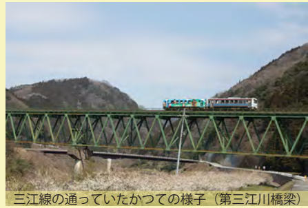
三三三線の通っていたかつての様子 (第三江川橋梁)
