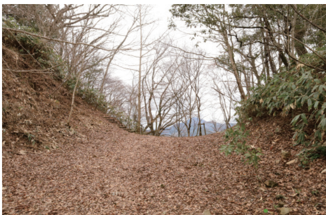
西の丸と神明丸間に、城内最大の数mの幅を誇る箱堀(はこぼり)。写真左手、西の丸側の落差は4~5mはある
