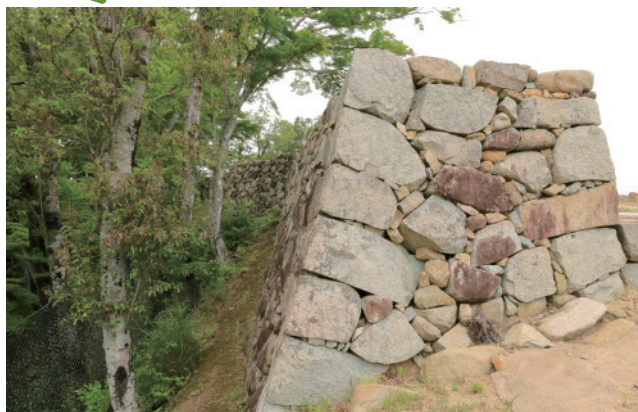
出丸の北石垣。途中で折れ横矢が掛かるようになっている構造にも注目
